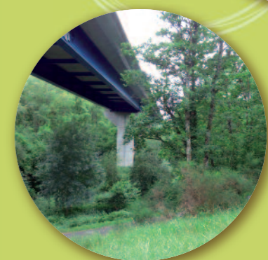
Les grandes infrastructures nécessitent des évaluations des incidences poussées
